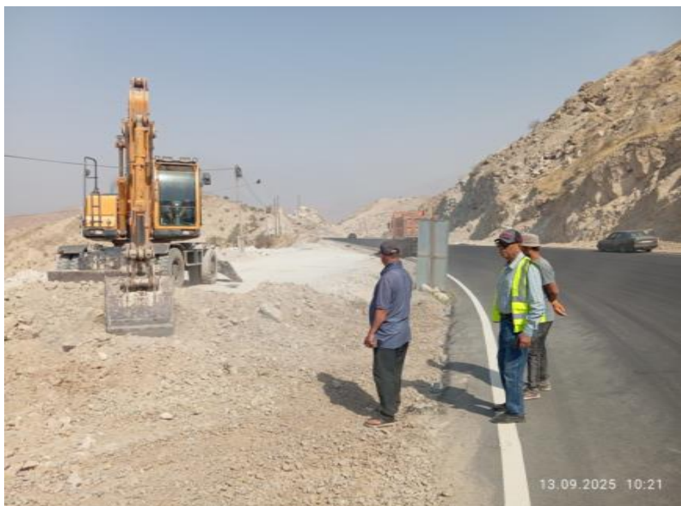
Строительные работы на объекте.
