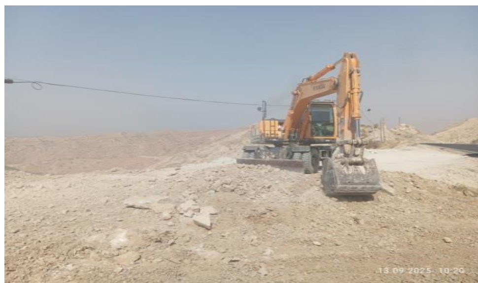
Строительные работы на объекте.
