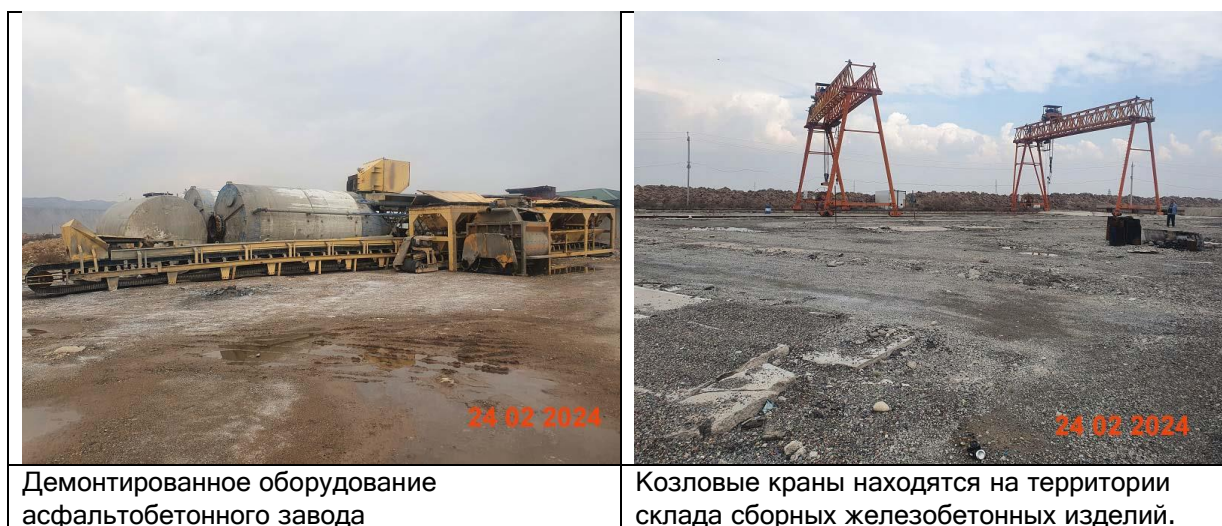
Рисунок 10. Текущее состояние бетонного завода и склада сборных железобетонных изделий на км 64 (справа)
