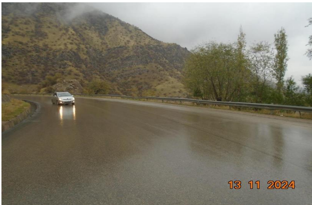
Фото 5. Км 66,7 ПС. Пример недавно поврежденного ограждения, требующего срочного ремонта/замены.
