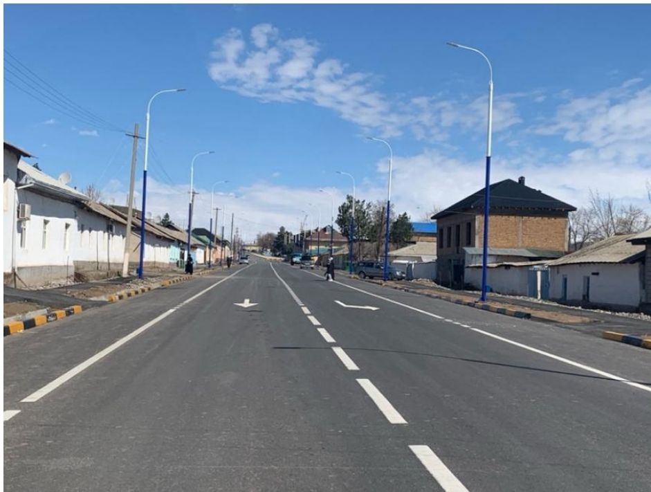
Завершение строительства дороги в населенном пункте в марте 2024 г.
