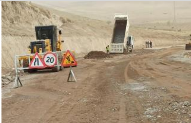
Фото 7: Предупреждающие знаки, установленные в зоне строительства, октябрь 2022 г.
