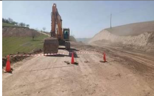
Фото 1: Работы по расширению дороги, октябрь 2022 г.
