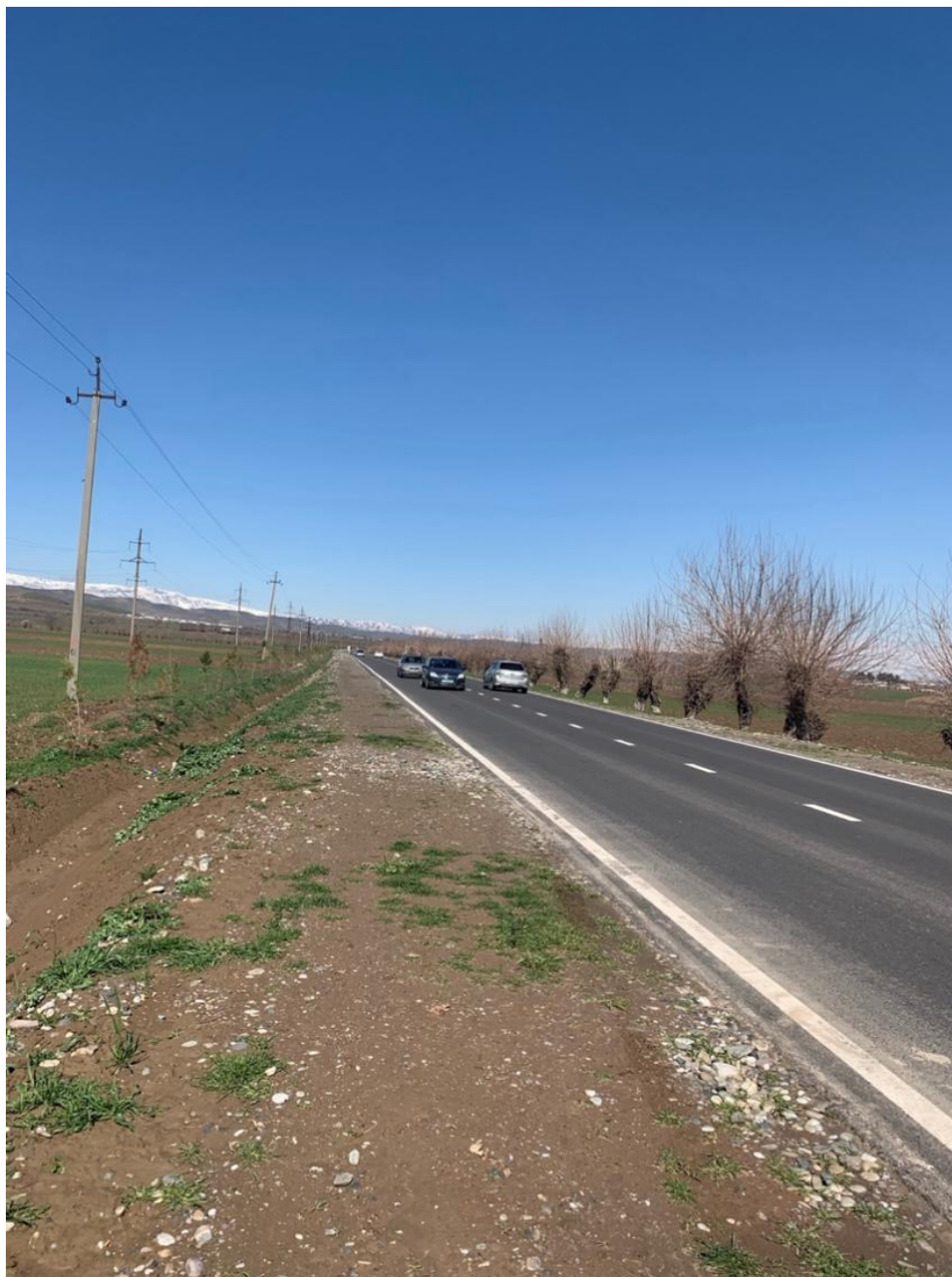
Завершение строительства дороги в отдаленном районе в марте 2024 г.
