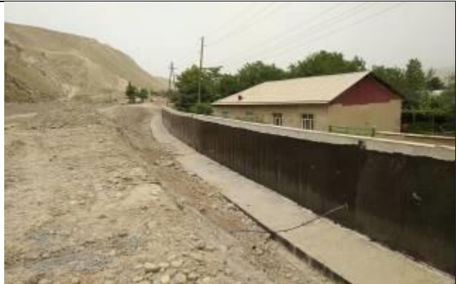
Фото 2: Строительство подпорной стенки, август 2022 г.
