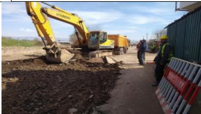
Фото 5: Земляные работы, октябрь 2022 г.
