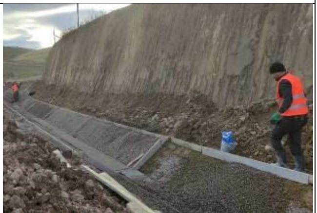
Фото 4: Строительство водопропускных труб, рабочие экипированы СИЗ, ноябрь 2022 г.
