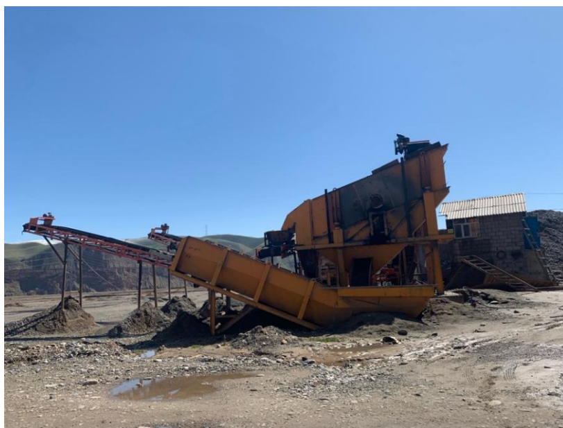
Дробилка для заполнителей по состоянию на март 2024 г.
