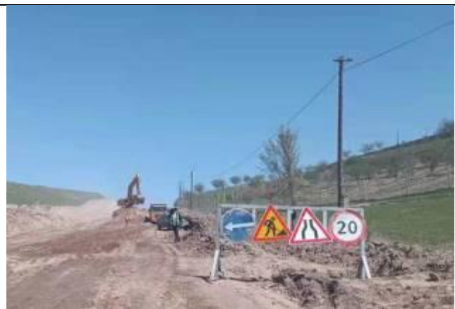
Фото 3: Выемка грунта, установка предупреждающих знаков, август 2022 г.
