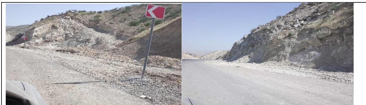
Место строительства дорожного объекта Лот-2
