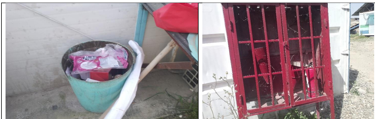
Непристойные строительные отходы в лагере оба объекта
