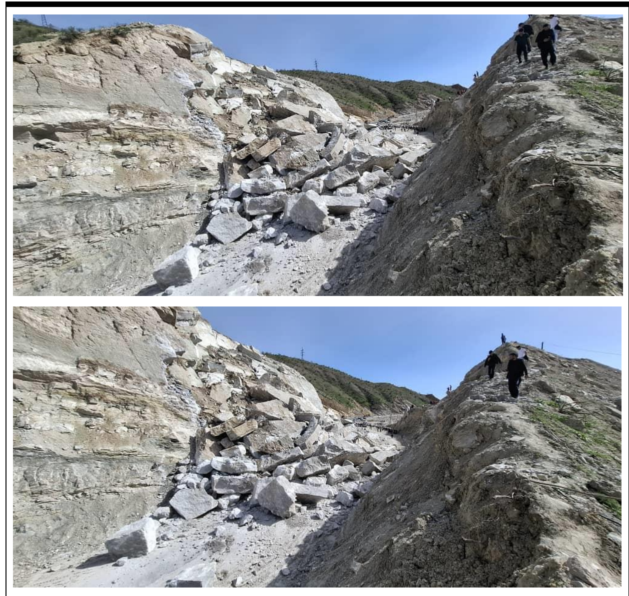
Рисунок 7 Оползень на участке км 186+40 – 187+40 /
