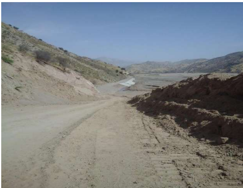
Рисунок 5– Существующая дорога на км 2,88
