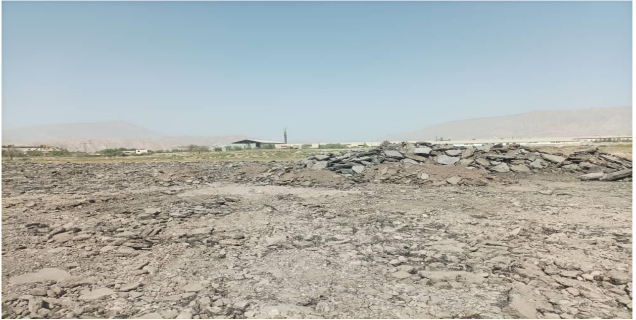
ПК 76+50 Отвал для хранения асфальт с левой стороны дороги. PK 76+50 Asphalt storage dump on the left side of the road.
