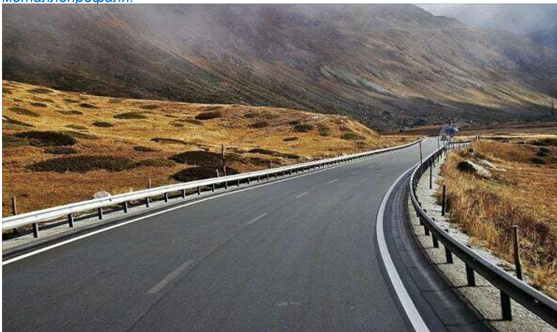
Рисунок 11. Наибольшее распространенное металлическое дорожное ограждение барьерного типа, изготавливаемое из специального металлопрофиля.
