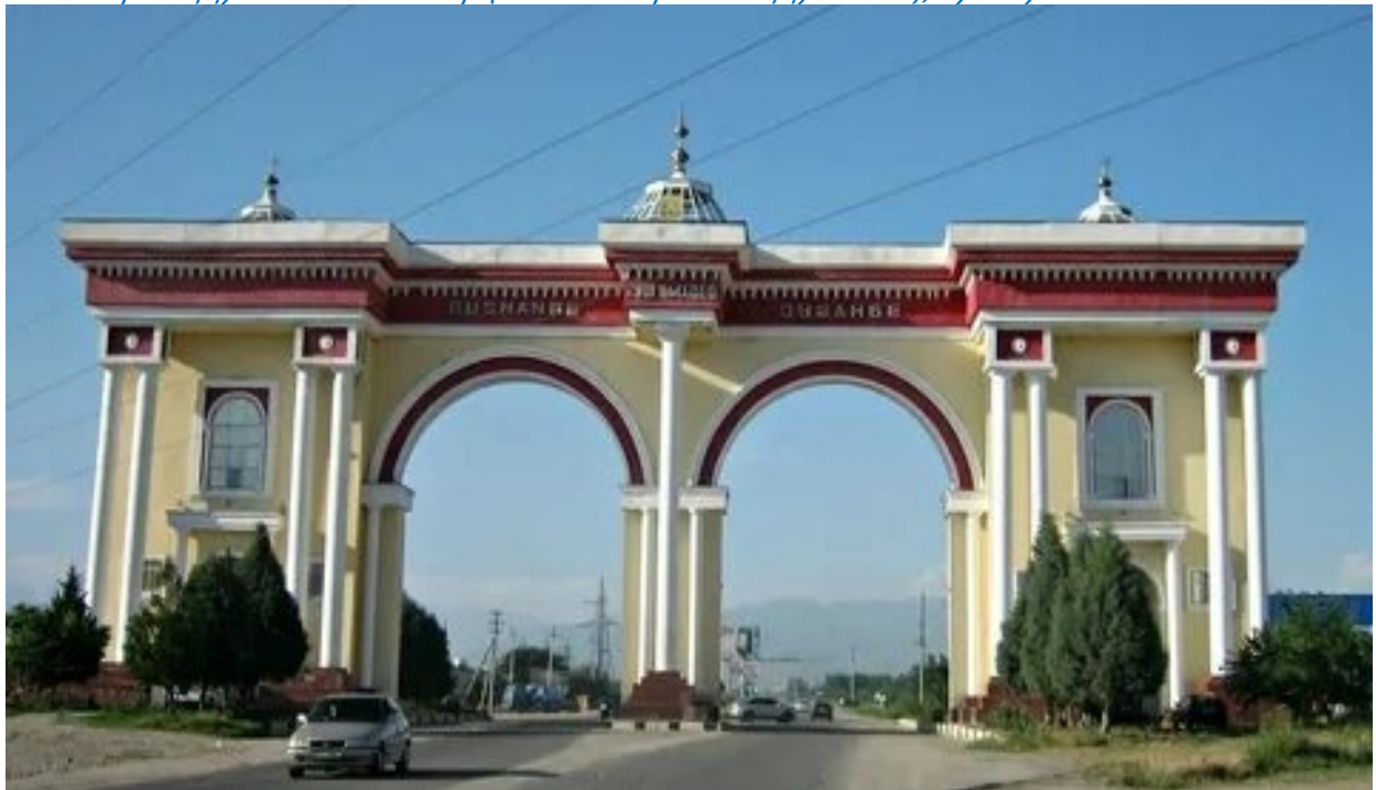
Рисунок 4. Автодорога автодорога Душанбе – Бохтар, южные ворота г. Душанбе, район Фирдавси, Гульбутта
